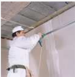
Na każdej ścianie wyznaczamy poziom zamocowania sufitu. Rysujemy poziome linie przy użyciu poziomnicy. Wzdłuż linii montujemy profile UD.
