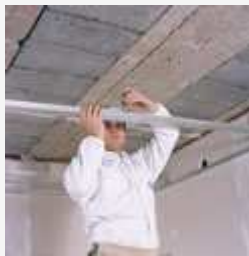
Po zamocowaniu profili UD na obwodzie pomieszczenia umieszczamy wieszaki i montujemy profile podłużne CD.
