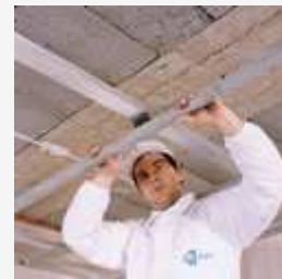
Prostopadle do już zamocowanych profili CD przytwierdzamy (na zatrzask) profile poprzeczne.
